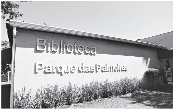
As obras visam proporcionar ambientes mais acolhedores e adequados para os frequentadores
