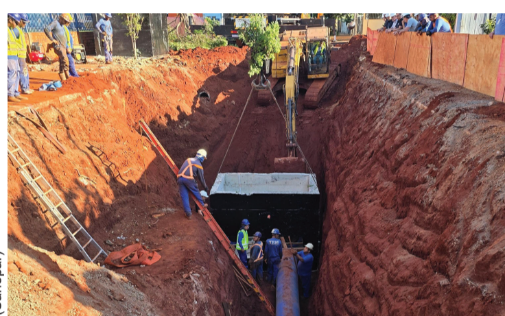
Sanepar conclui etapa crucial da obra que duplica capacidade de água na Zona Norte
